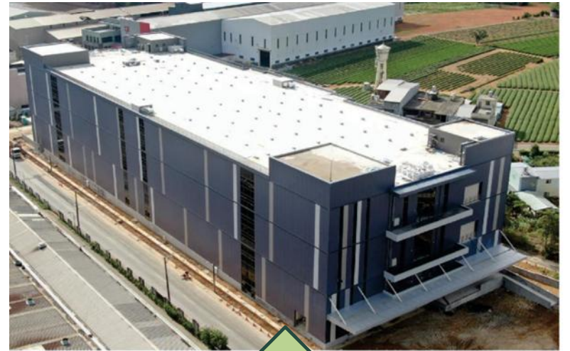
龍潭智能園區-A棟倉庫
